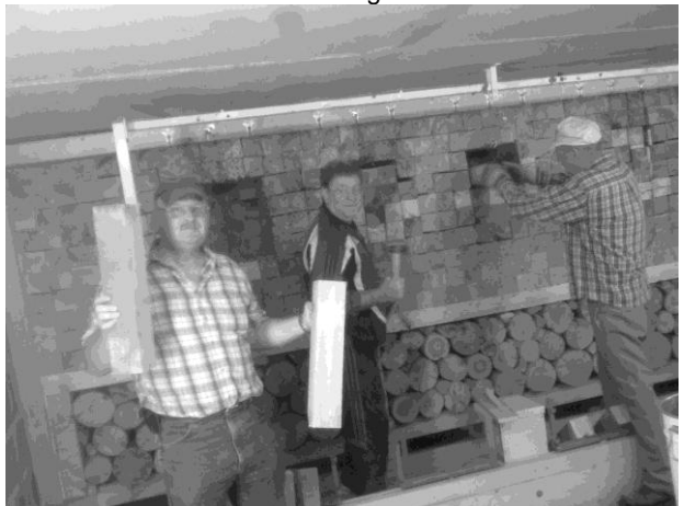
Die Mannschaft mit dem staubigsten Arbeitsplatz: der 25 m Stand wird erneuert
